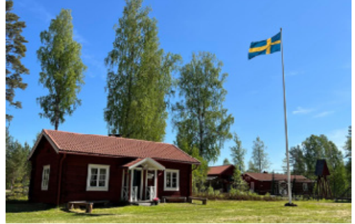
Den nyrenoverade Almastugan
